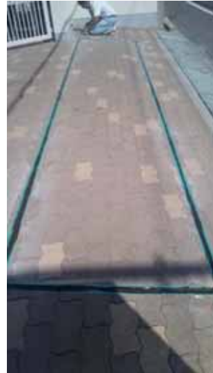
トリガコイル施工写真
