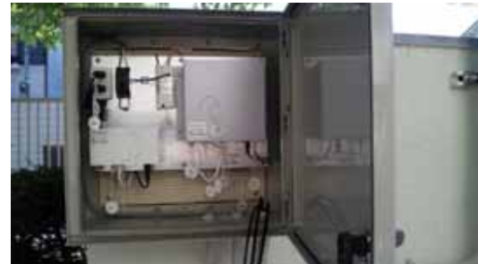
トリガコイルドライブユニット設置写真
